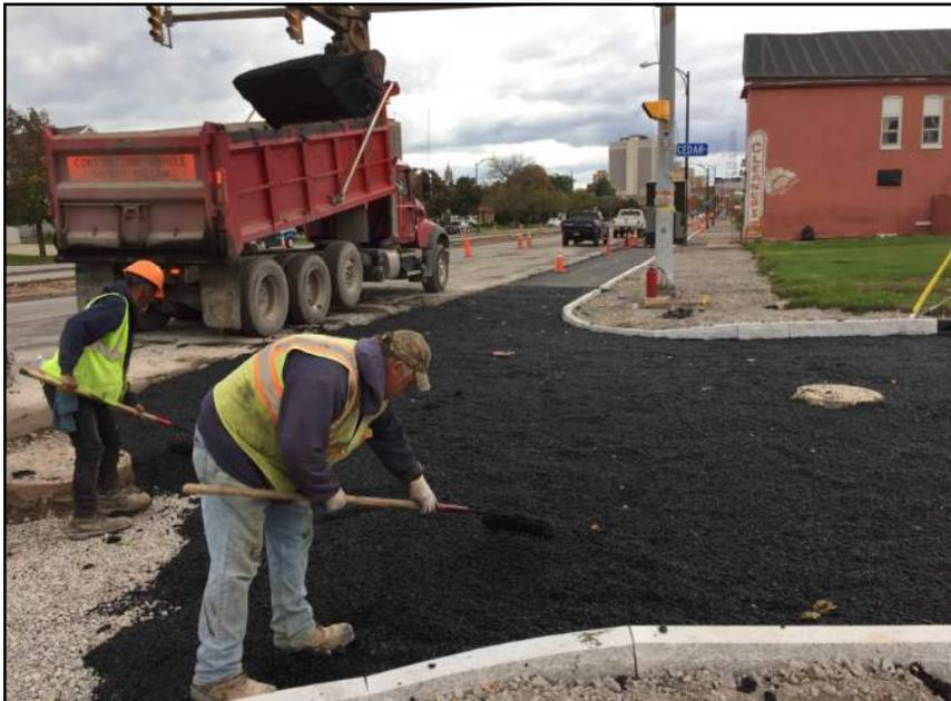
**POROUS ASPHALT - CONSTRUCTION**
